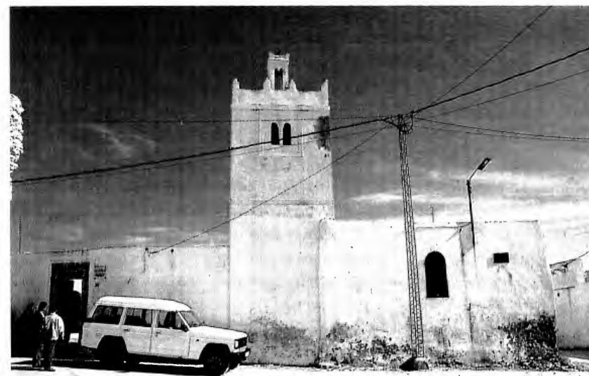
Fig.2- Le minaret et la façade.
